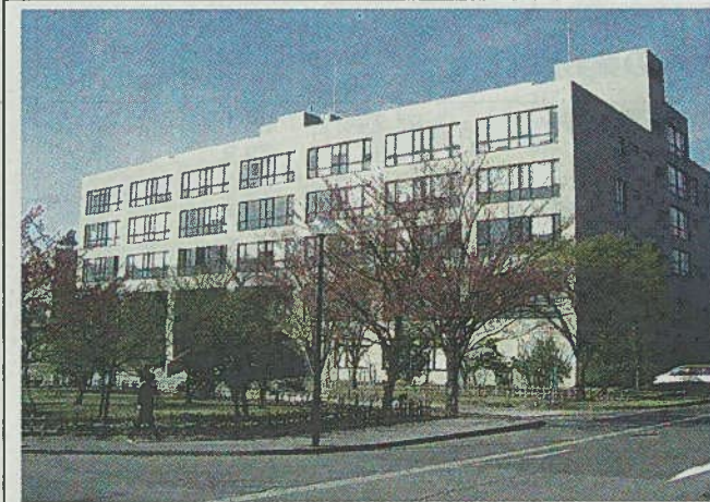
金沢労基署から是正勧告を受けた北陸大学=金沢市太陽が丘で
